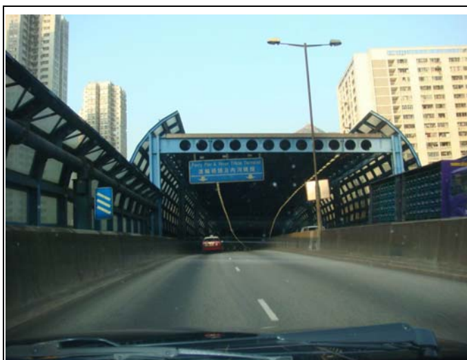
沿屯門公路21出口往 屯門(西) 穿過大鐵筒
